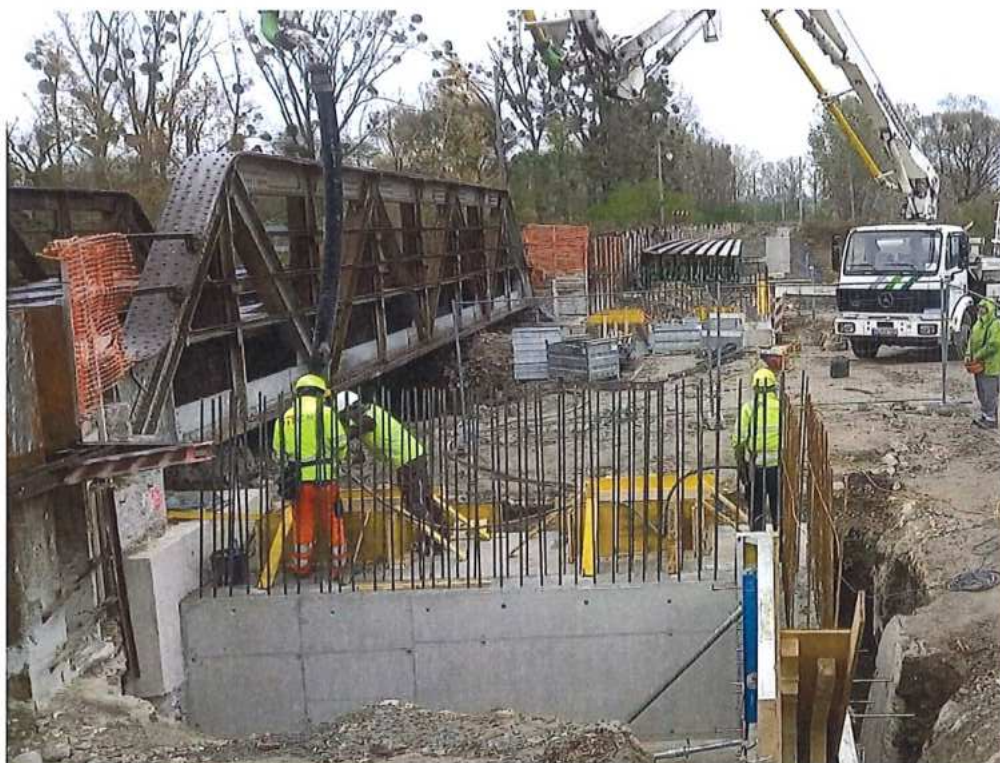
Betonáž podložiskových bločkov - SO 12-33-01
