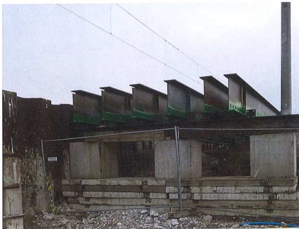
Zváranie nosníkov - SO 12-33-02
