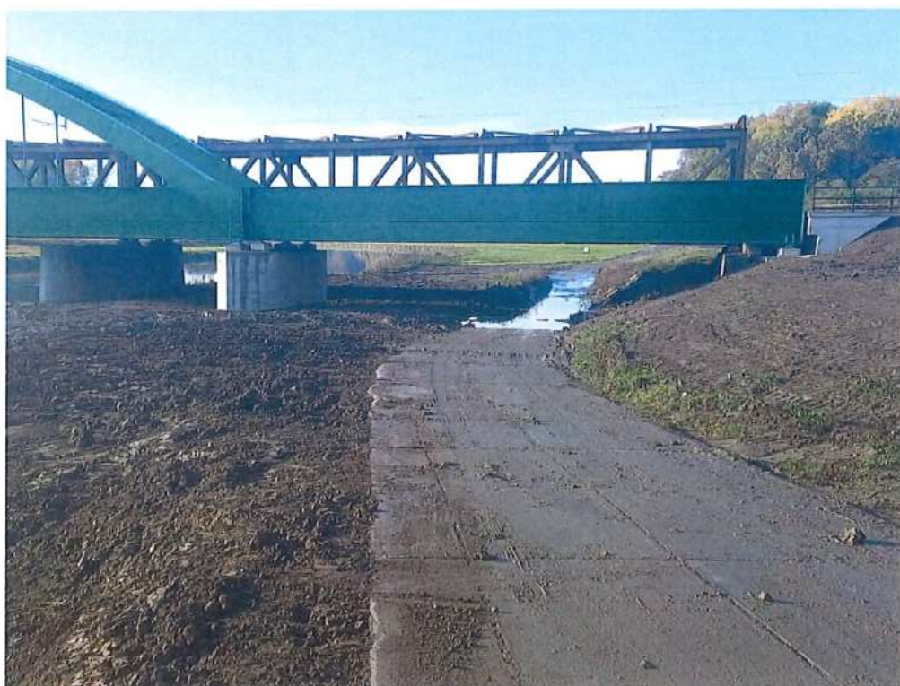
Terénne úpravy napojenia protipovodňovej hrádze pod SO 12-33-04
