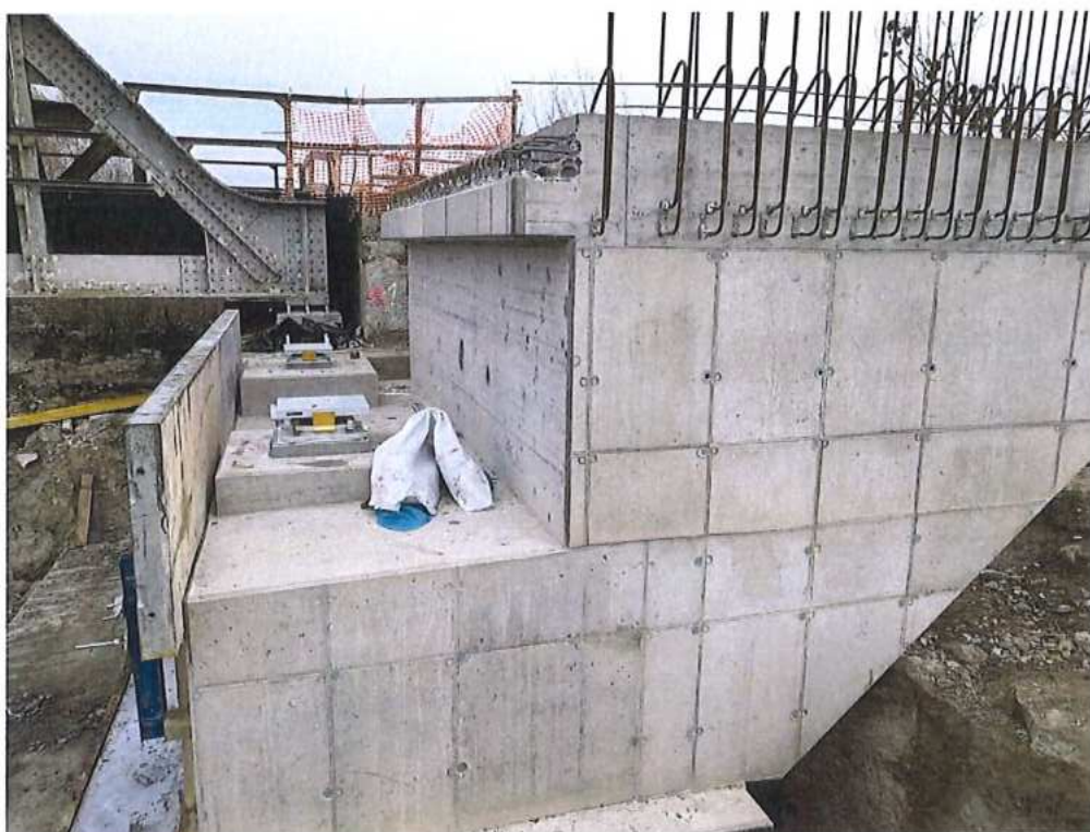
Montáž ložísk na opore č. 1 - SO 12-33-01
